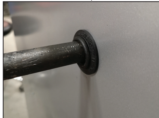
FIGURE 28 - RACCORDEMENTS DE LA CONDUITE DE GAZ DE LA FOURNAISE (NOTEZ L'ANNEAU EN CAOUTCHOUC)
