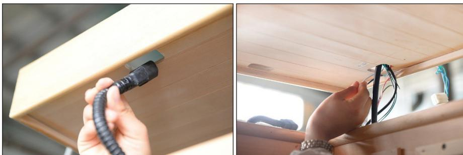
\* En plaçant le toit sur le sauna, faites passer chacun des câbles de chauffage sur les parois latérales et arrière, ainsi que le faisceau de câbles et la fiche d'alimentation dans le coin arrière gauche, par les trous correspondants sur le périmètre du toit.
