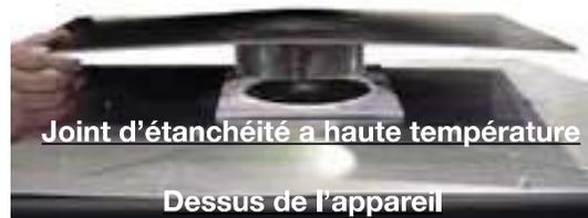
**Pour un cheminée en maçonnerie, utilisez un support de tuile. Pour une cheminée préfabriquée, utilisez une plaque d'ancrage.**
