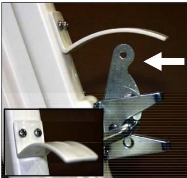
Étape 2: Placez le protecteur de loquet au-dessus du loquet et vérifiez que celui-ci dispose de l'espace nécessaire pour fonctionner correctement. Centrez le protecteur et fixez-le avec deux vis #10 x 3/4 fournies.
