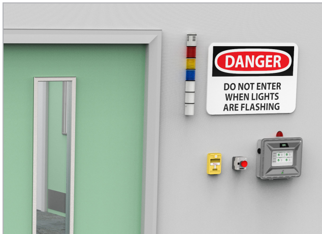
L'écran distant situé à l'extérieur de la salle des machines rend la signalisation possible depuis l'entrée
