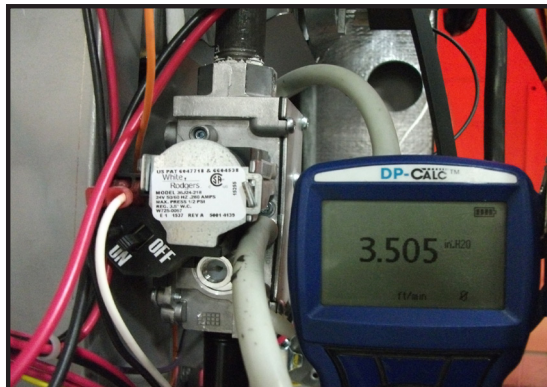
FIG. 30. - MANOMÈTRE QUI MESURE LA PRESSION DU GAZ AU COLLECTEUR
