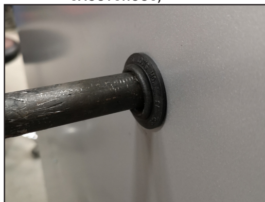
FIGURE 28 - RACCORDEMENTS DE LA CONDUITE DE GAZ DE LA FOURNAISE (NOTEZ L'ANNEAU EN CAOUTCHOUC)
