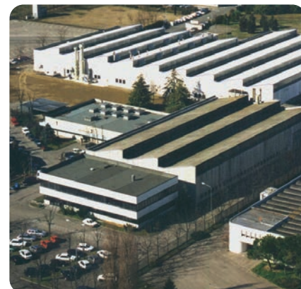
FAENZA (Ravenna) CISA S.p.A. | Sede central Sede administrativa, oficinas y R&D
