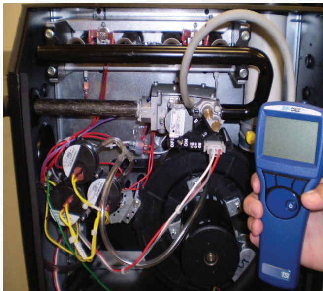
FIGURE 27 - MANOMÈTRE QUI MESURE LA PRESSION DU GAZ AU COLLECTEUR
