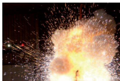
Arc flash 7 kA
