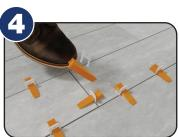
Una vez que el mortero fragüe, retírelo en la dirección de la línea del rejuntado dentro de las 24 horas
